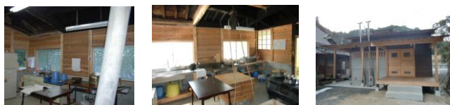
a. 台所二期工事前 b. 台所二期工事後 c. 五右衛門風呂
