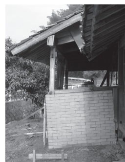
写真3 O 邸浴室腰壁
