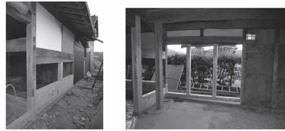
写真3 土台・足固め・柱の交換部
