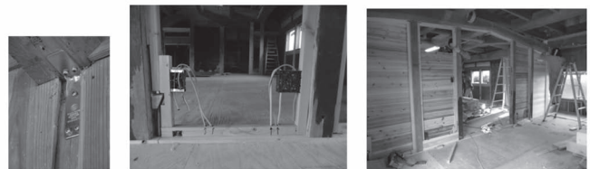
写真4 耐力壁の取付け
