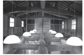
(d) 2階吹き抜け
