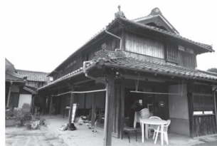
写真2 納屋外観(改修前)
