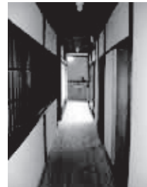
写真6 廊下(東棟西側)
