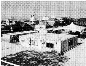
写真9 元気ハウス外観
